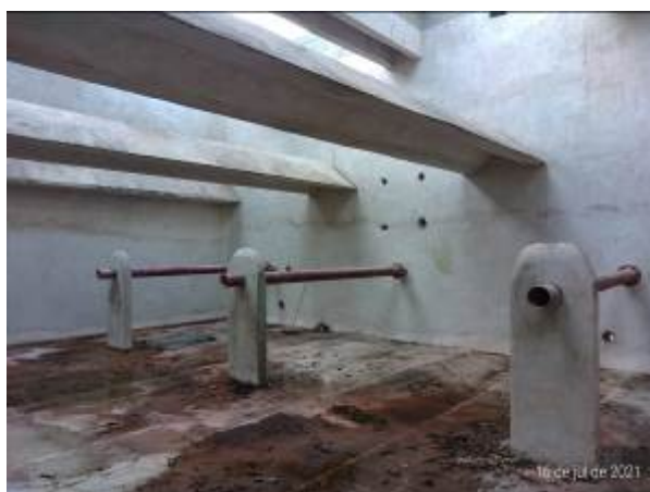
Foto 03 – Reator UASB (Interior)
