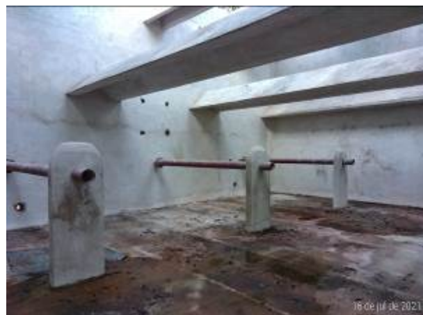
Foto 04 – Reator UASB (Interior)
