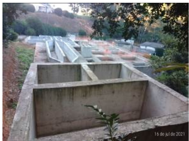
Foto 01 – Caixa de Areia / Gradeamento
