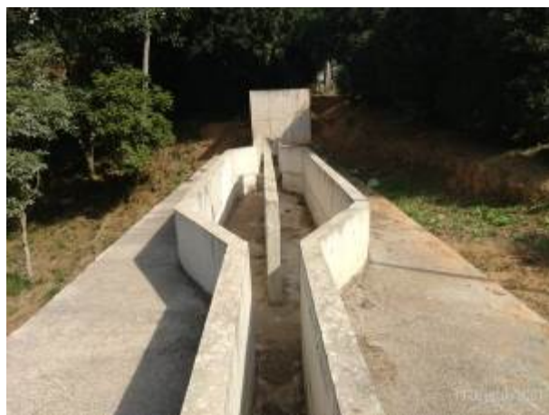
Foto 02 – Caixa de Areia / Gradeamento
