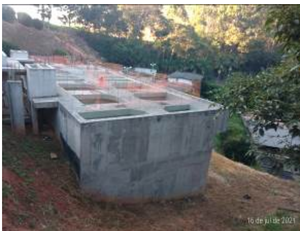
Foto 01 – Reator UASB (Exterior)
